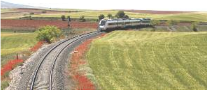
Línea ferroviaria en la que va a intervenir Adif
