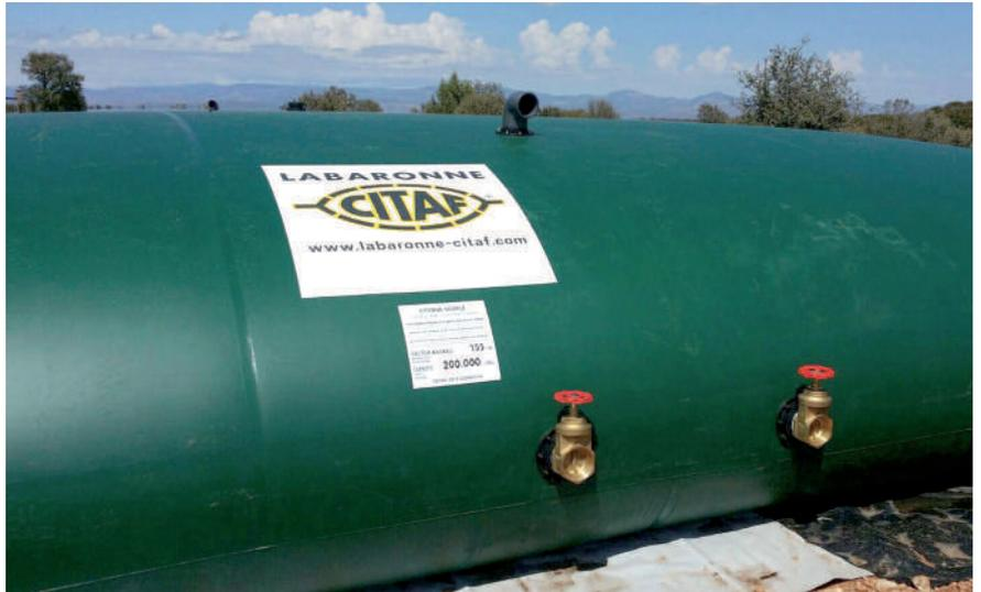
Detalles de las bocas, que pueden colocarse en diferentes puntos de la cisterna
