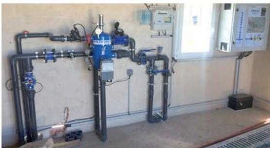
Estación de filtración y control totalmente automatizada
