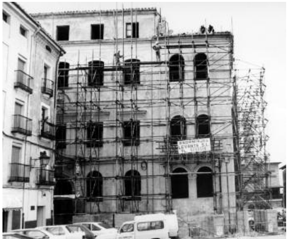
Obras de rehabilitación del edificio para su conversión en la Escuela de Hostelería. Archivo DIARIO DE TERUEL
