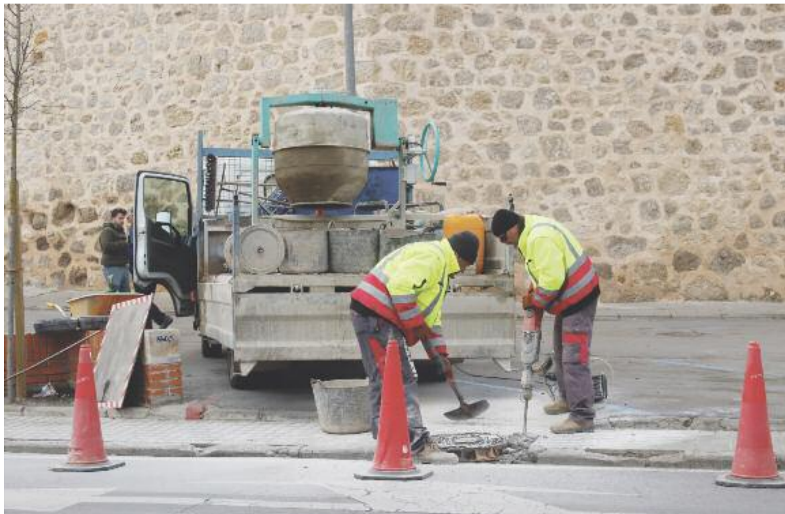
Unos operarios reparan el alcantarillado en la ronda Dámaso Torán de la ciudad de Teruel
