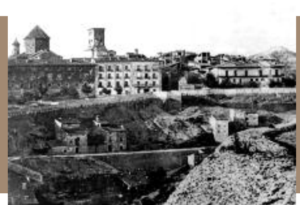
3 Muralla junto al Portal de Valencia. Novella, A. (1988)
