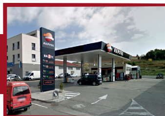
UBICACIÓN: Gasolinera barrio San León DIRECCIÓN: Carretera de Alcañiz, 56
