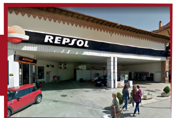
UBICACIÓN: Gasolinera Repsol Ensanche DIRECCIÓN: Avenida de Sagunto, 5
