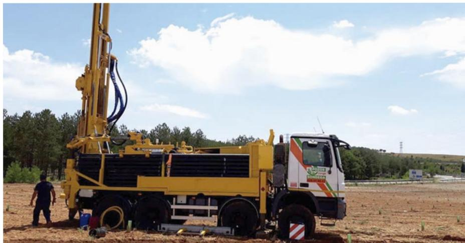
Ejecución de un pozo para la captación de agua
