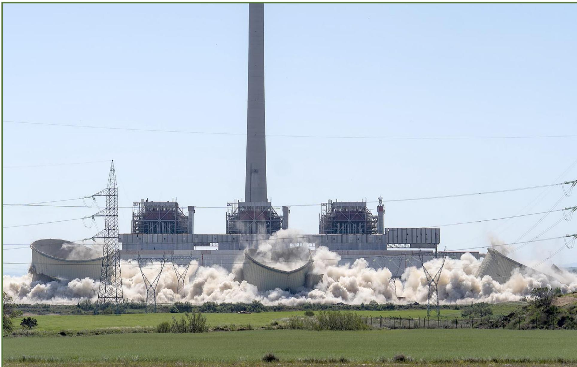
**ANDORRA DICE ADIÓS A SU CENTRAL TÉRMICA CON LA DEMOLICIÓN DE LAS TRES TORRES DE REFRIGERACIÓN.** A las 11:30 horas del viernes 13 de mayo se demolieron las torres de refrigeración de la central térmica de Andorra. Se emplearon 275 kilos de explosivos para una detonación controlada, la primera que se realizaba de una instalación de estas características. Bykofoto
