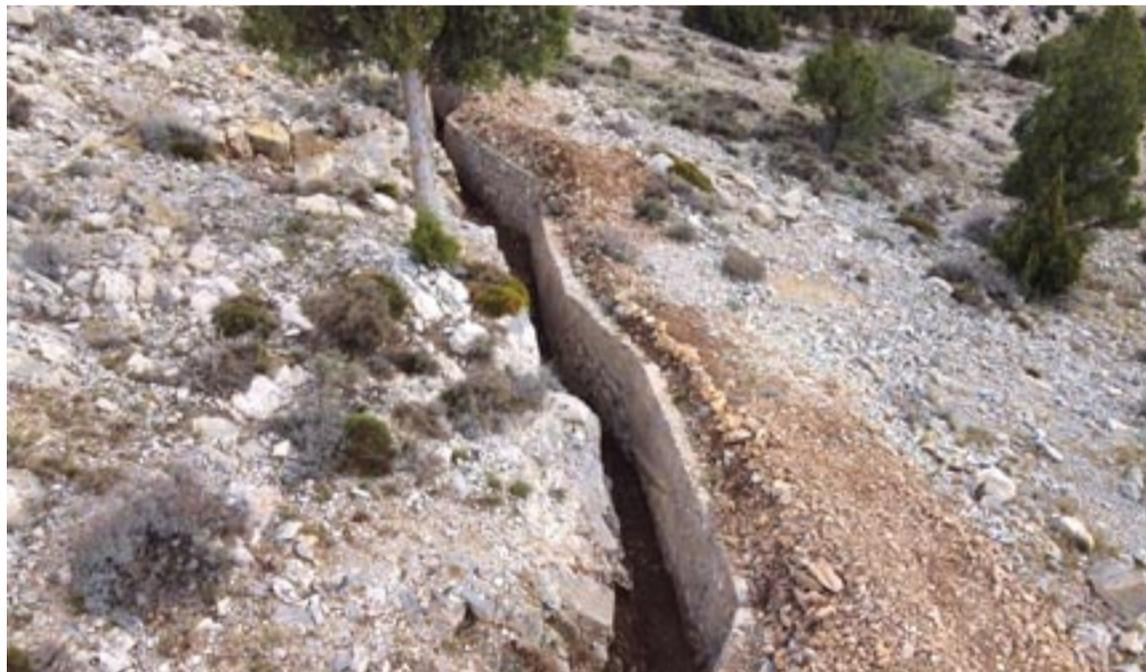
Cabigordo (Corbalán): Trinchera reforzada con muros de mampostería trabada con mortero de cemento.
