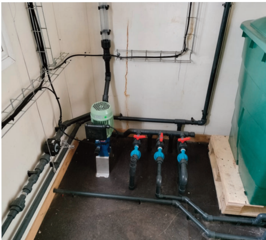
Llaves de paso para regular el riego en las diferentes secciones de la parcela
