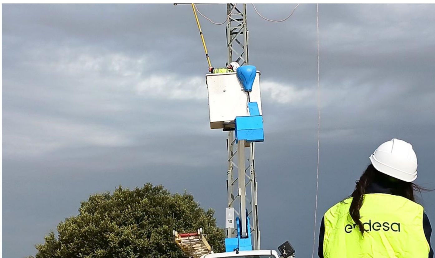
Un técnico de Endesa supervisa un trabajo en campo
