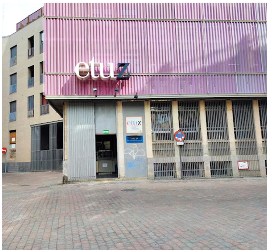
Exteriores de las instalaciones de la Escuela Universitaria de Turismo en Zaragoza
